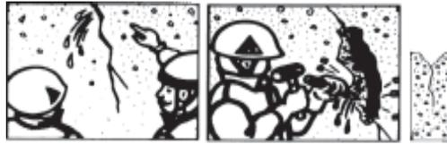
Đục bê tông hoặc đá hình chữ “V” xung quanh nơi rỉ nước. Làm sạch những mảnh vụn vữa, tạp chất và làm sạch bề mặt bằng nước trước khi thi công Sika 102.
